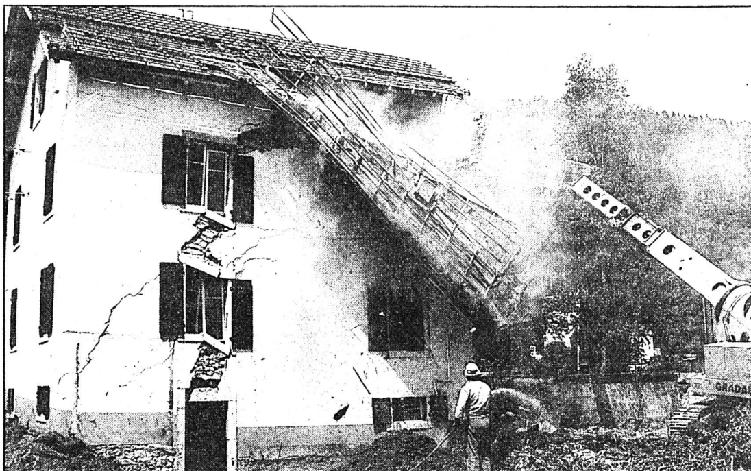
On démonte à Chézard.
