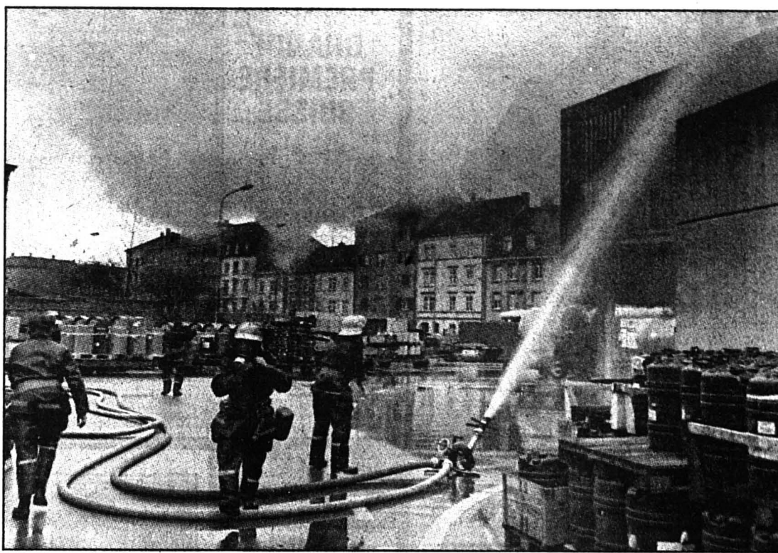
Les pompiers sont intervenus rapidement sur les lieux du sinistre.
