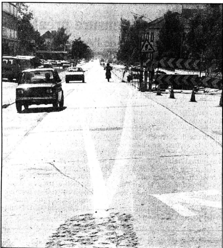
Malgré une curieuse double ligne médiane (?) à l'entrée du chantier, la signalisation de celui-ci s'est notablement améliorée. (Photo Impar-Perrin)
