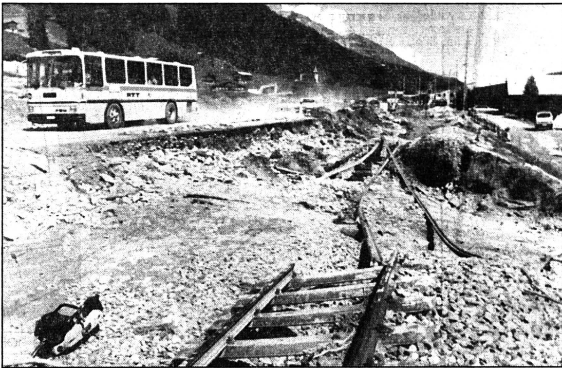
La ligne ferroviaire Davos-Filisur a été coupée.
