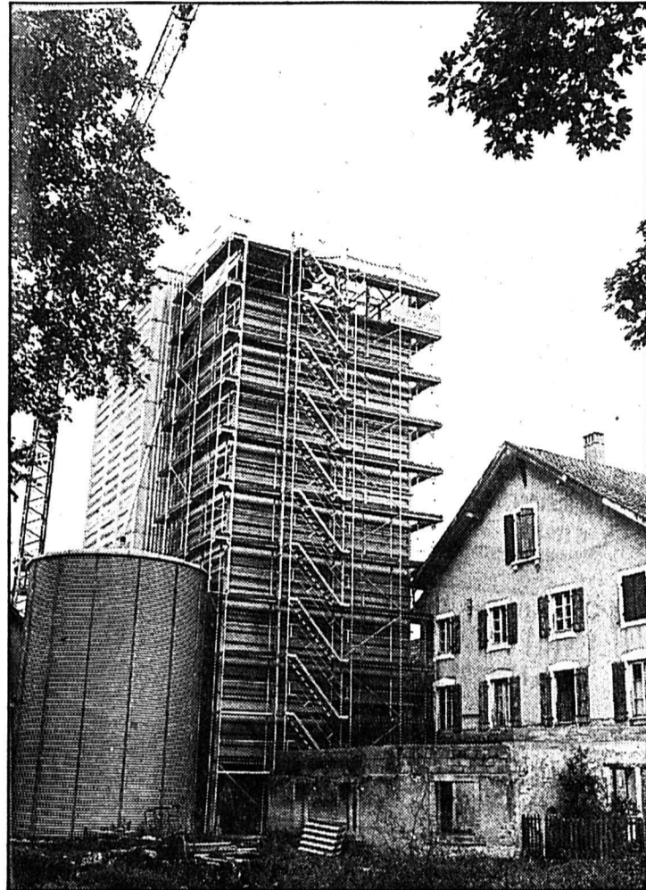
Le silo en construction. Capacité: 500 tonnes. (Impar-Charrère)
