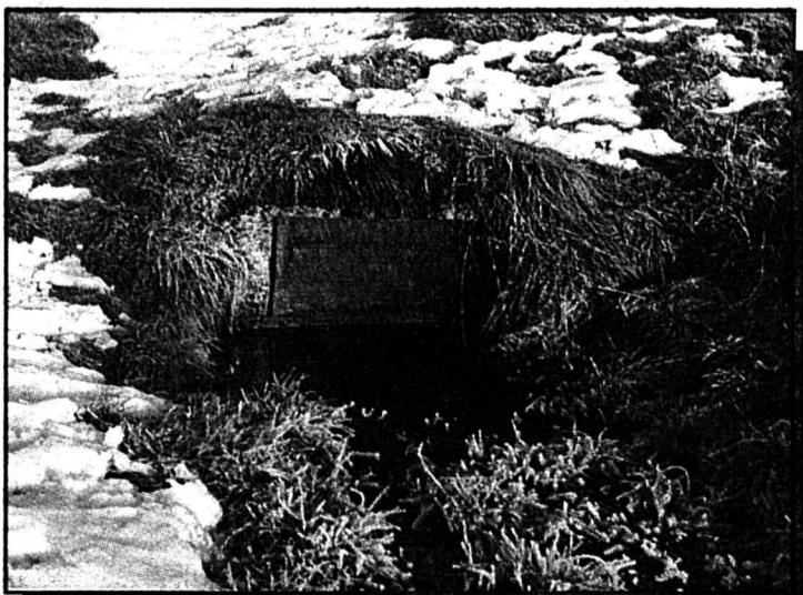
Le captage de la source de la Bonne-Fontaine
