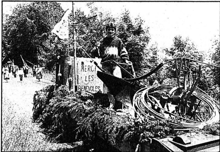
Le char de la télévision. En vedette: le bénévolat et la charrie qui a creusé le sol pour enfouir le câble...
