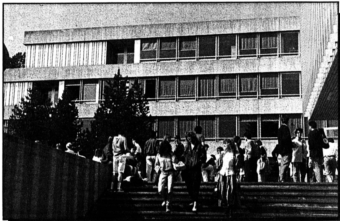
Le crédit de 8,4 millions destiné à l'assainissement du Gymnase cantonal de La Chaux-de-Fonds a trouvé grâce auprès des Neuchâtelois qui ont daigné emprunter le chemin des urnes.
