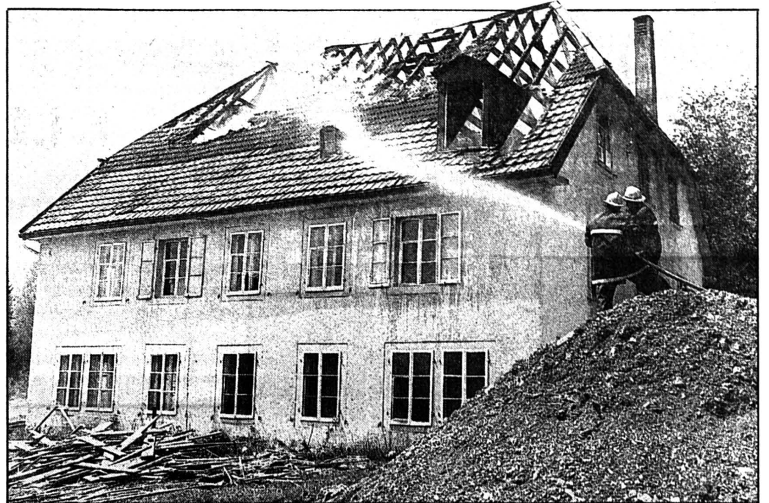
Du toit, il ne restait que quelques poutres calcinées.
