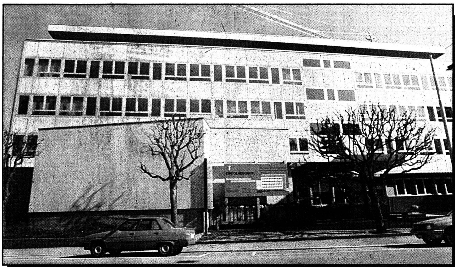
L'Ecole d'ingénieurs du canton de Neuchâtel, au Locle.
