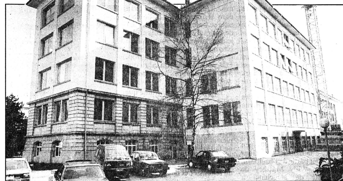
L'ex-Tech passera sur le billard: aménagement et reprise en sous-oeuvre.
