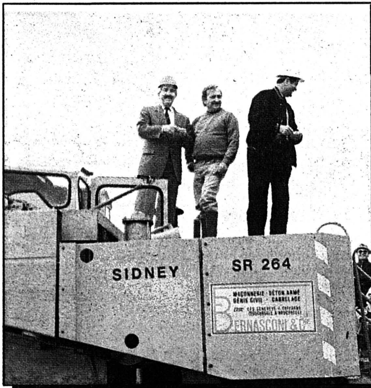
A. Brandt a mis la main à la pâte lors des premiers travaux du tunnel sous La Vue-des-Alpes. (Photo Schneider)
