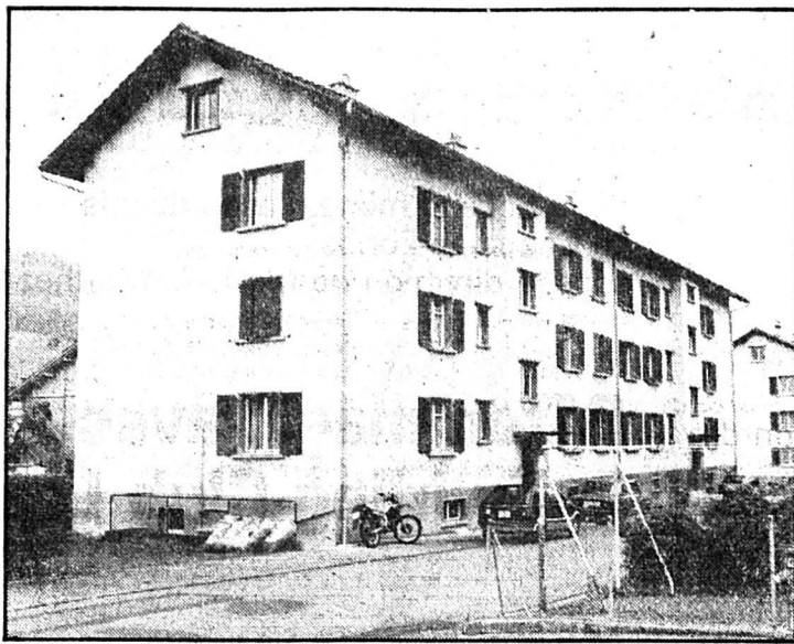
Immeubles Dubied à Couvet. Plus de 250 locataires sur le fil du rasoir. (Impar-Charrère)
