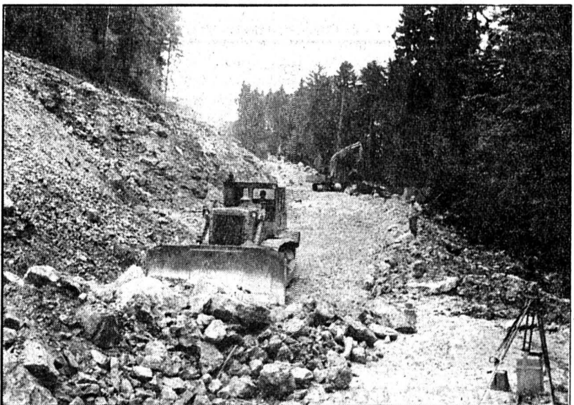
Secteur 4: Construction de la piste d'accès au portail sud du tunnel des Hauts-Geneveys
