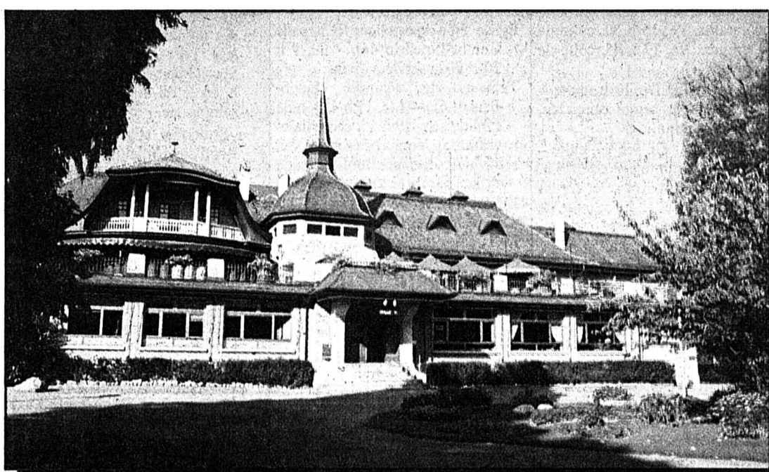
La Rotonde sera démolie pour faire place au théâtre.
