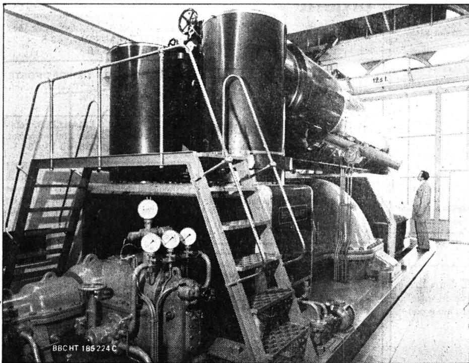
La turbine de Champ-Bougin. Taux de compression: 4,4/température des gaz chauds à l'entrée: 537°C.
