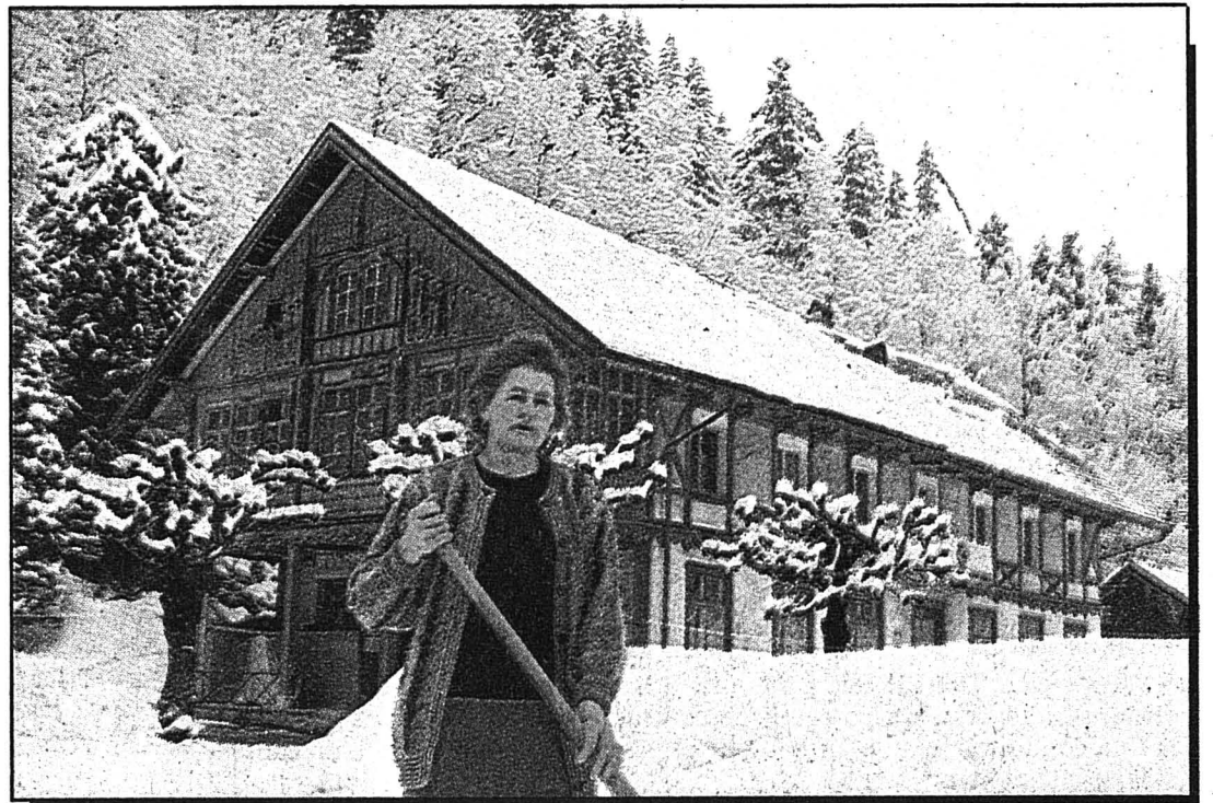
Mme Yvonne Fankhauser devant son restaurant promis à la démolition.
