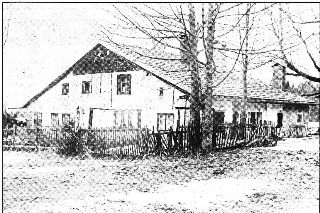
Mont-Pugin 8, cette ancienne ferme neuchâteloise sera rénovée et transformée pour pouvoir héberger collectivement de 20 à 30 personnes. (Photo Impar - Perrin)
