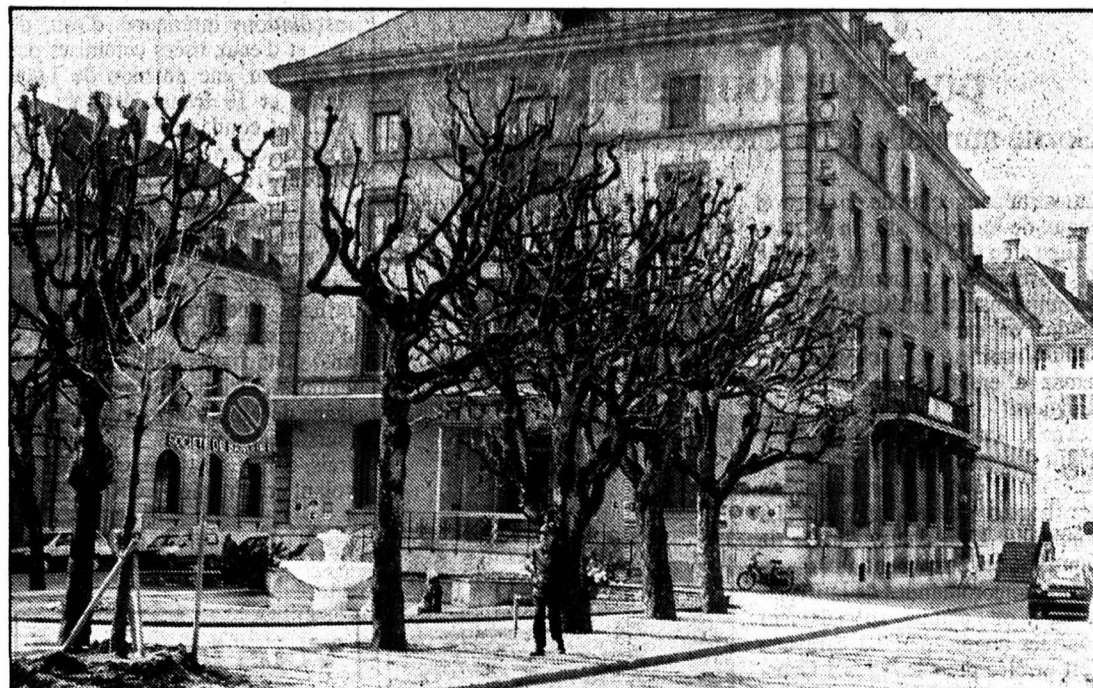
L'ancien Hôtel des Trois Rois: démolition reportée à une date inconnue pour des raisons administratives. Le promoteur enrage... (Photo Impar-Perrin)
