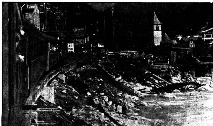
Essai de transport sur la voie mise mal en point au-dessus de Gurtellen. (Bélino AP)
