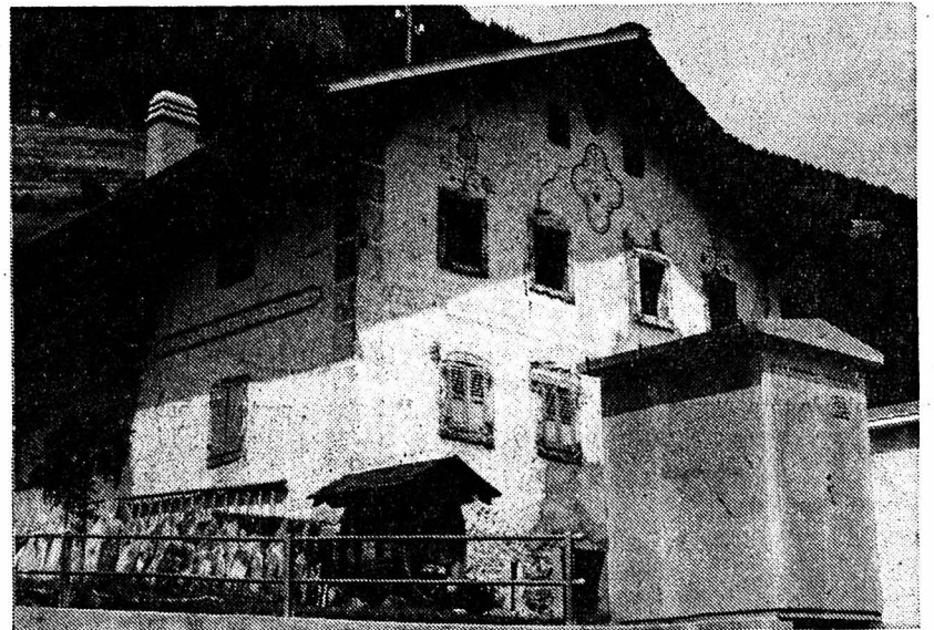
L'électricité, en Valais, aussi, ne sait pas se faire discrète.
