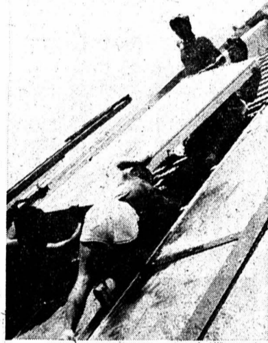
Pose de capteurs solaires sur la nouvelle halle omnisports de la Maladière à Neuchâtel. Les panneaux solaires sont destinés à préparer l'eau chaude sanitaire pour les douches des sportifs.
