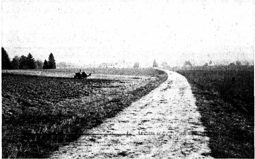
Entièrement bétonné, le chemin reliant La Chaux-des-Breuleux au Roselet permettra une exploitation rationnelle des terres. (Texte et photo ac)
