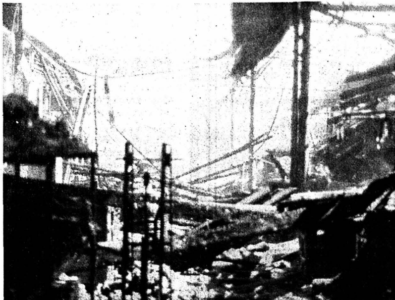
Une image qui donne une idée de l'importance des dégâts. (Photo rs)
