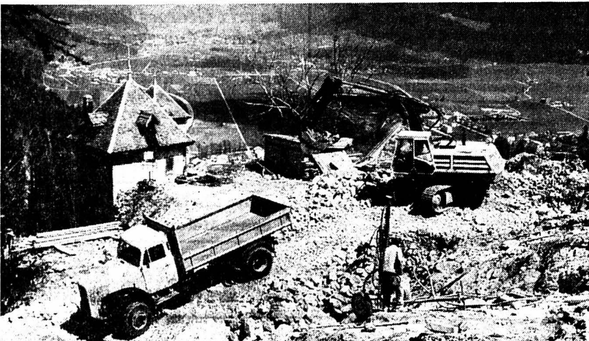
Excavation des rochers. Un chantier entre ciel et terre. (Impar-Charrère)
