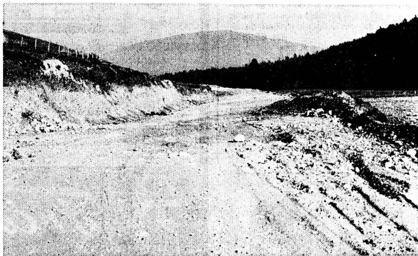
Coffrane: le «périphérique sud» destiné aux camions des gravières. (Photo Impar-ms)
