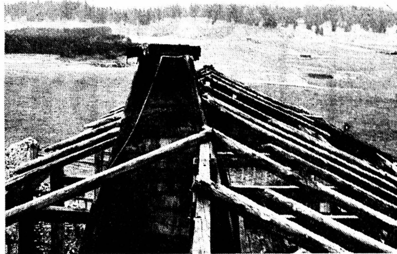
Le toit dénudé, au moment de la réfection
