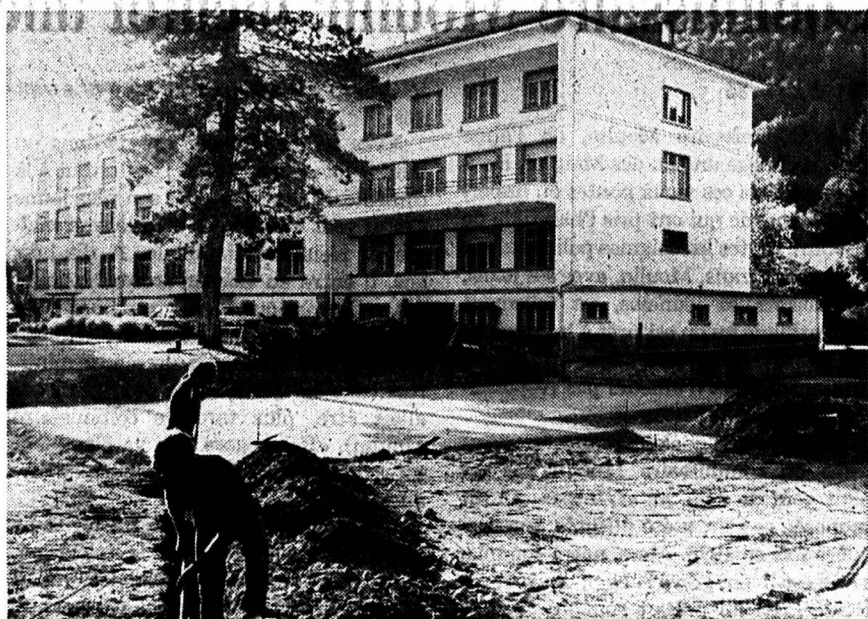
L'Hôpital de Fleurier. A droite, on prépare la construction de la nouvelle aile. (Impar-Charrère)
