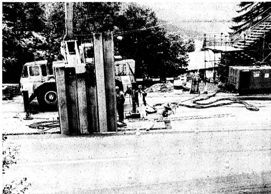
Les palplanches serviront à renforcer la chaussée pendant que l'on creusera le souterrain sur l'autre partie de la route.
