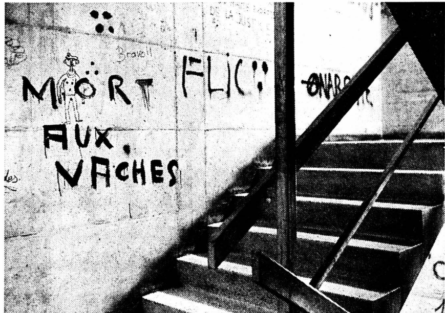
Une alternative aux ascenseurs, la cage d'escaliers et ses murs qui parlent. (photo Impar-Gerber)
