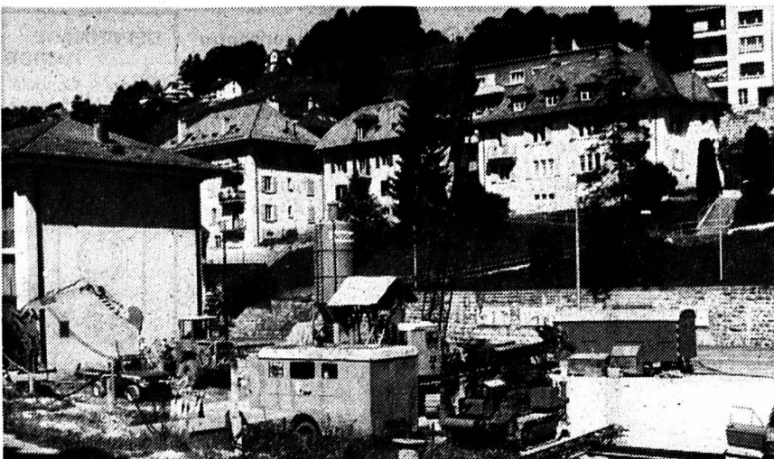
Ici s'élèvera une nouvelle usine. (Photo Impar-Perrin)
