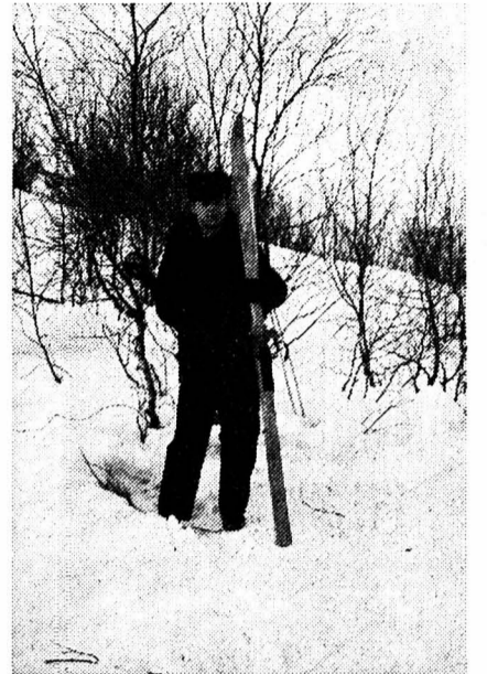
Un contrôleur et son matériel démodé.
