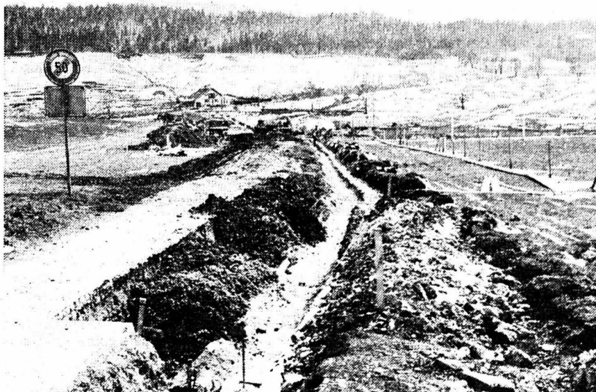
Des travaux d'envergure pour doter la future usine d'infrastructure routière et énergétique adéquate. (Photo Impar-cm)
