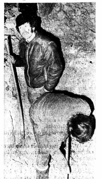
Il n'est pas facile de creuser la terre lorsque la température est descendue à moins 27 degrés. Une conduite d'eau ayant sauté au quartier de Sur-la-Côte, il a fallu un soir, à la lumière des lampions, réparer de toute urgence. La terre gelée jusqu'à une profondeur de 1,20 mètre nécessita les grands moyens, la pelle rétro et le marteau-piqueur monté sur chenillettes. Notre photo, le nettoyage final avant la réparation. (z)
