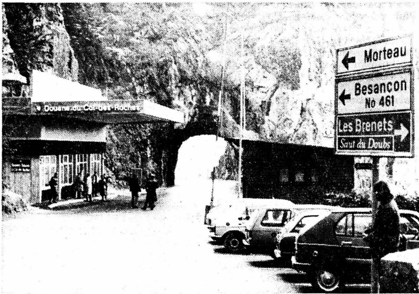
En face de l'ancien pavillon à droite, le nouveau bâtiment implanté au pied de la paroi rocheuse dont les machines ont excavé 400 mètres cubes. Au fond le tunnel de la Vierge déjà sur territoire français. (Photo Impar-Perrin)
