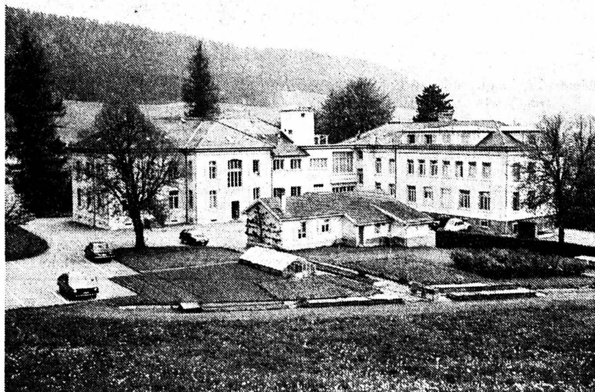
L'arrière de l'hôpital de Couvet. Le bâtiment de droite sera démolé. Le nouveau s'élèvera dans le champ, jusqu'au contrefort du Rossier. (Impar-Charrère)
