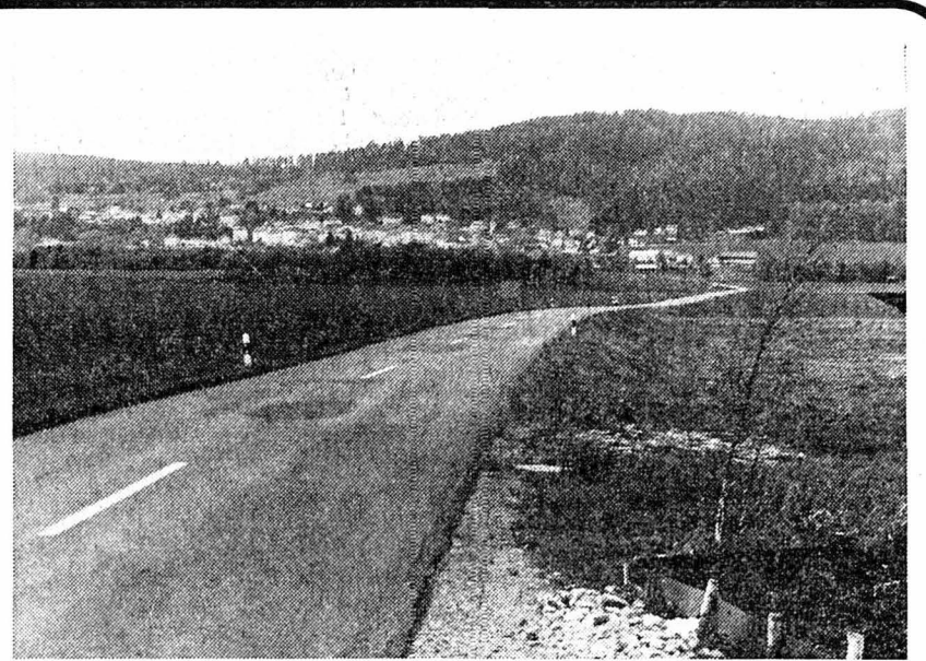
Entre Les Ponts-de-Martel et Les Petits-Ponts, une amélioration nécessaire avec la construction d'un trottoir.
