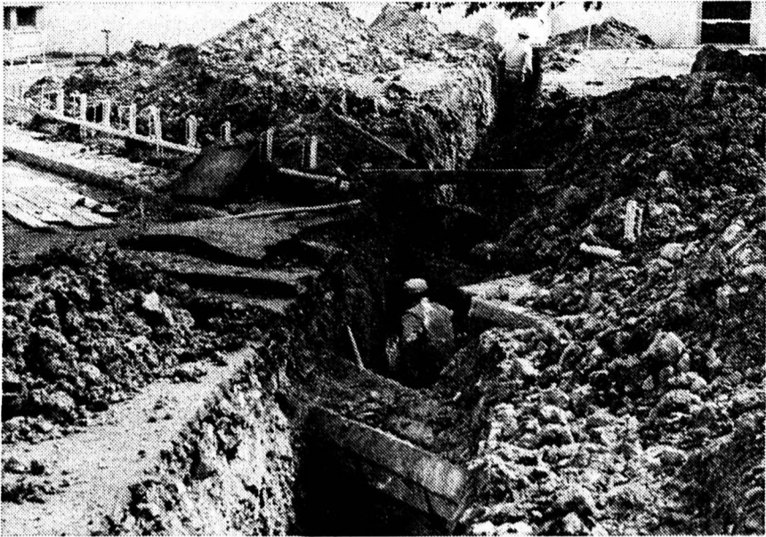
Les ouvriers terminent le creusage de la fouille et arrivent à proximité des installations techniques de la piscine-patinoire.
