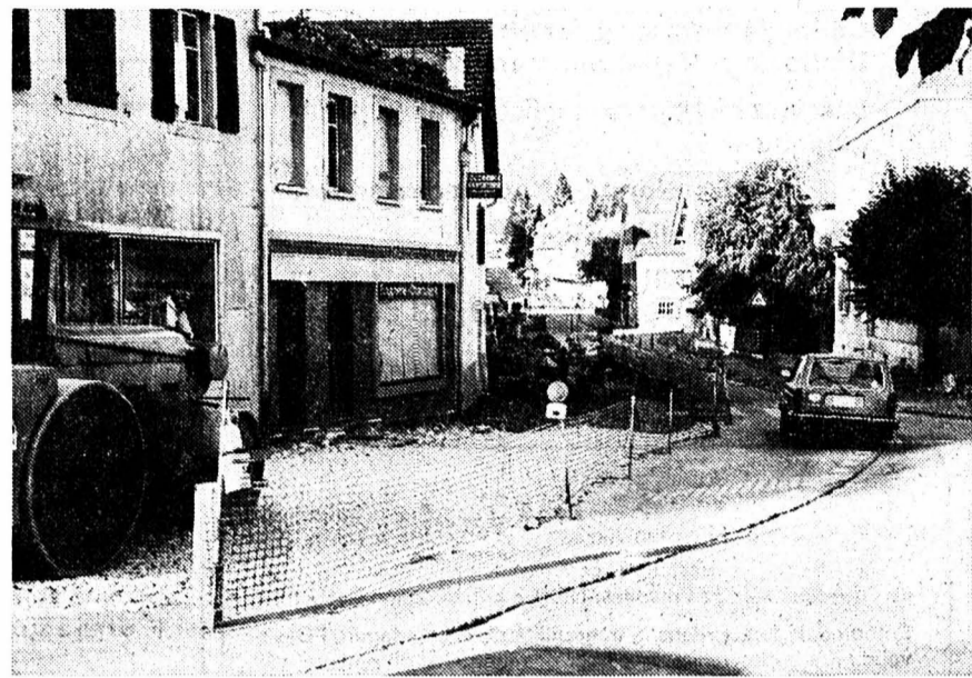
Les travaux de correction de la T30 sont déjà bien avancés.
