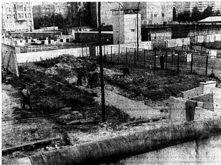
A Berlin-Est, des pionniers de l'armée est-allemande commencent le travail de reconstruction du poste de contrôle nommé Charlie, réservé au passage des étrangers et des diplomates. (Bélino AP)
