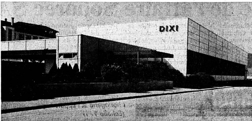
Double hall climatisé pour le montage des aléseuses et centres d'usinage
