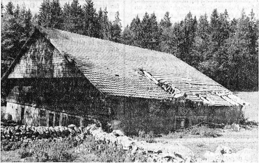
La ferme de la Baume. Ramée de tavillon désintégrée et toit défoncé par la chute de la cheminée. A sauver de toute urgence. (Impar-Charrère)
