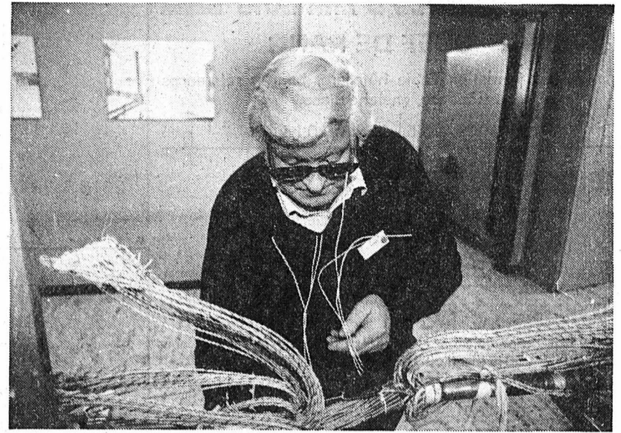
Les raccordements dans les câbles peuvent aussi être effectués «à la main». (Photo ICJ)
