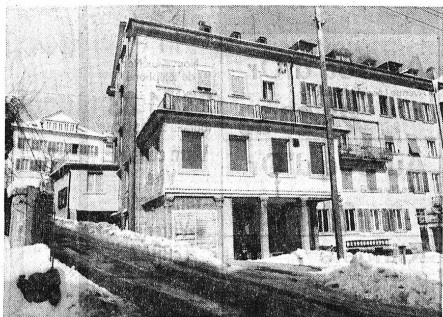
Le bâtiment qui sera transformé et agrandi grâce à l'esprit d'initiative des membres du Cercle ouvrier.
