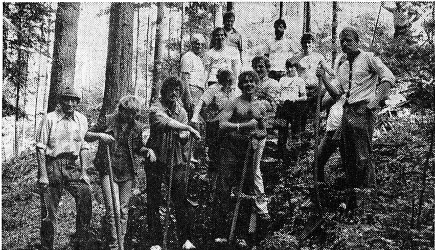
Il est midi, ce deuxième samedi de travail, et le chemin d'accès de près de 800 m. est aménagé jusqu'au pied de la tour.
