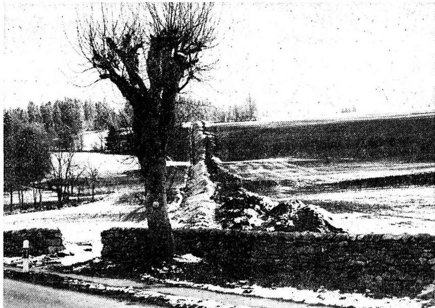
La nouvelle conduite est déjà posée sur la grande partie du tronçon mais ne sera rebouchée que lorsque des essais auront été effectués. Notre photo montre une portion de cette conduite près de Saignelégier, à la limite de la commune du Bémont. (pve)
