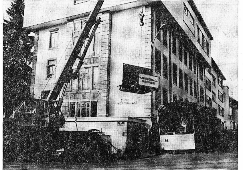
Après bien des polémiques, un scanner a été installé à la clinique Montbrillant
