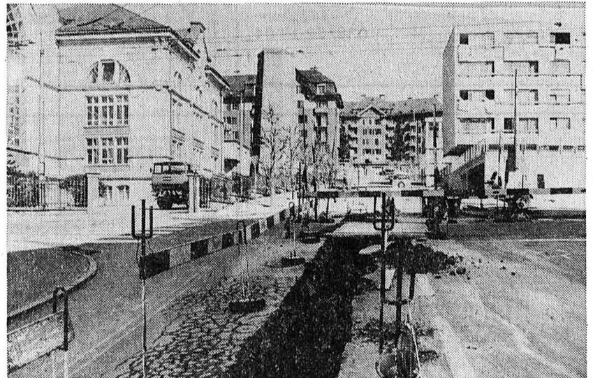
La ville se transforme en fromage de gruyère pour les besoins de l'arrivée du gaz naturel
