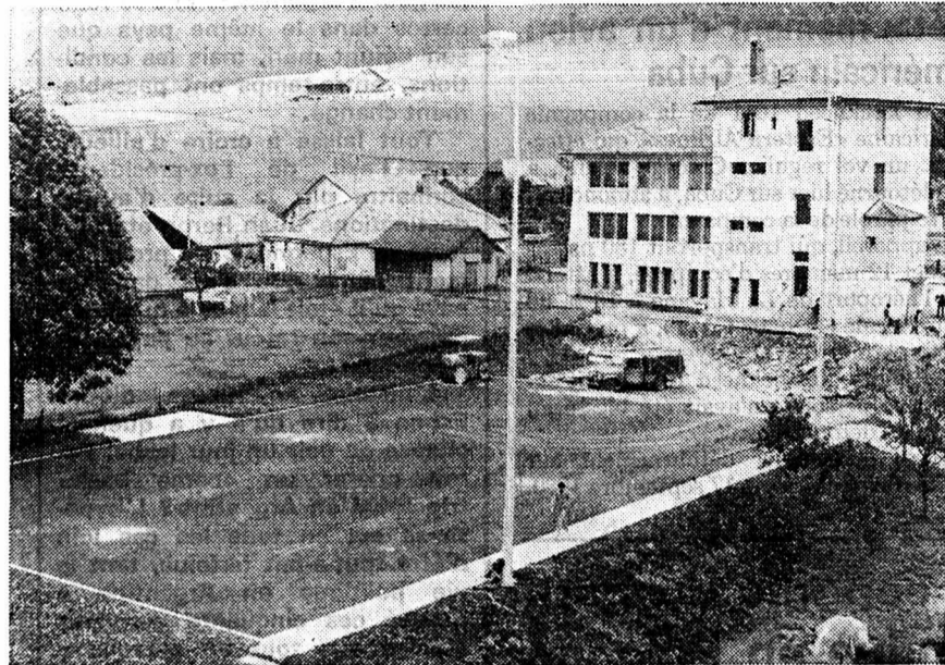
Une vue générale de la place de jeux depuis le clocher du collège.
