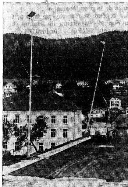
La pose de projecteurs effectuée au moyen d'un camion-grue. A l'arrière-plan, le collège primaire.
