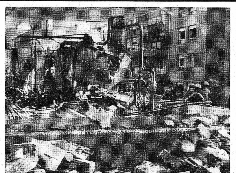
Le réservoir de propane dont l'explosion a provoqué le drame. (bélino AP)
