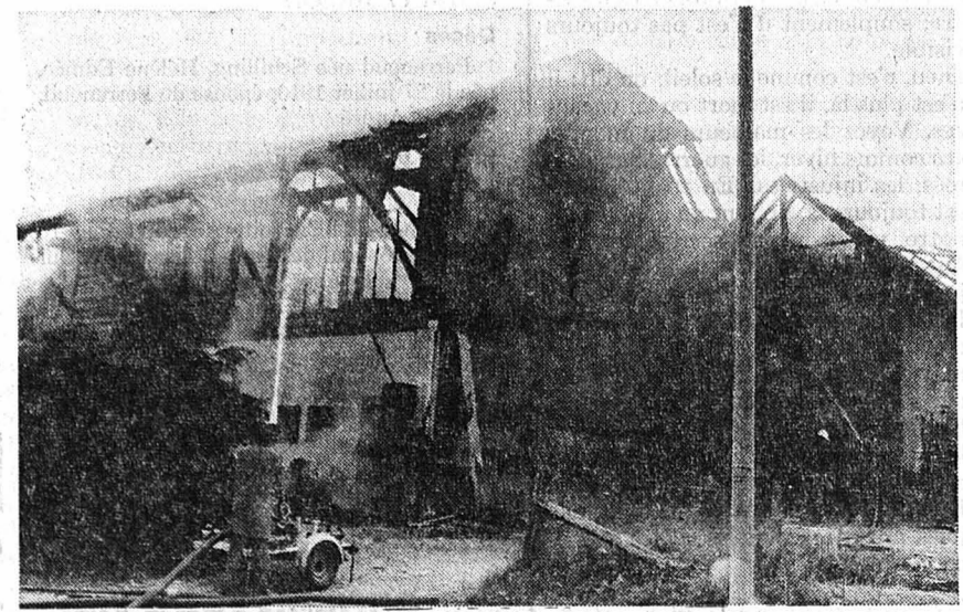
La grange et la remise ont été totalement détruites.
