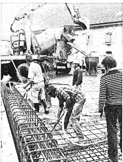
Les ouvriers en train de couler la dalle. (Photo Impar-Charrère)
