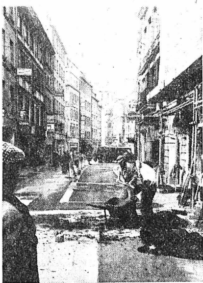
Les travaux se poursuivent activement à la rue de l'Hôpital mais, tout comme la Grand-Rue, cette artère sera inaugurée en tant que « piétonne » au mois de mai. (Photo Impar-RWS)
