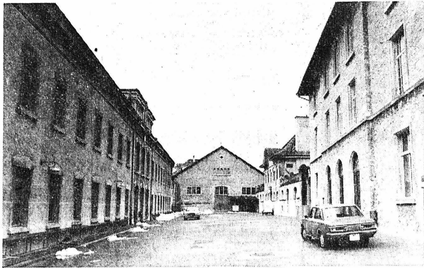
En face, le manège. De part et d'autre, les casernes: trois bâtiments qui vont faire l'objet d'un réaménagement complet.
