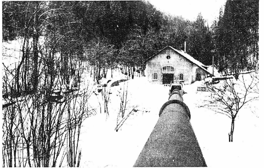
Arrivée de la conduite forcée à la Rançonnière. Environ dix mètres avant l'usine, on installera un raccordement qui alimentera le troisième groupe qui sera installé dans un bâtiment construit à gauche de la photo.
