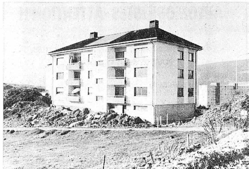
La Résidence « Le Solarium » est aujourd'hui pratiquement terminée.
