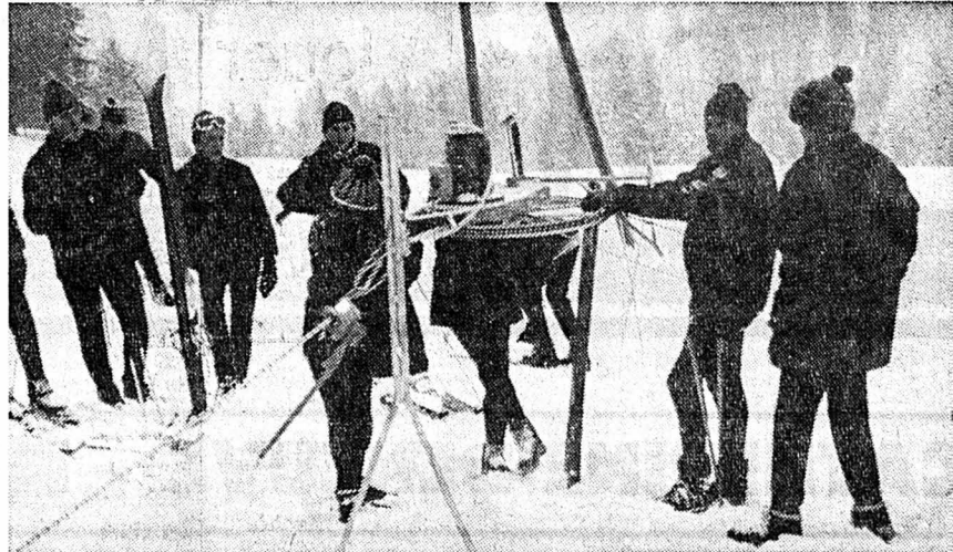
C'est sous une tempête de neige que l'on procéda à l'installation des divers éléments du remonte-pente.
