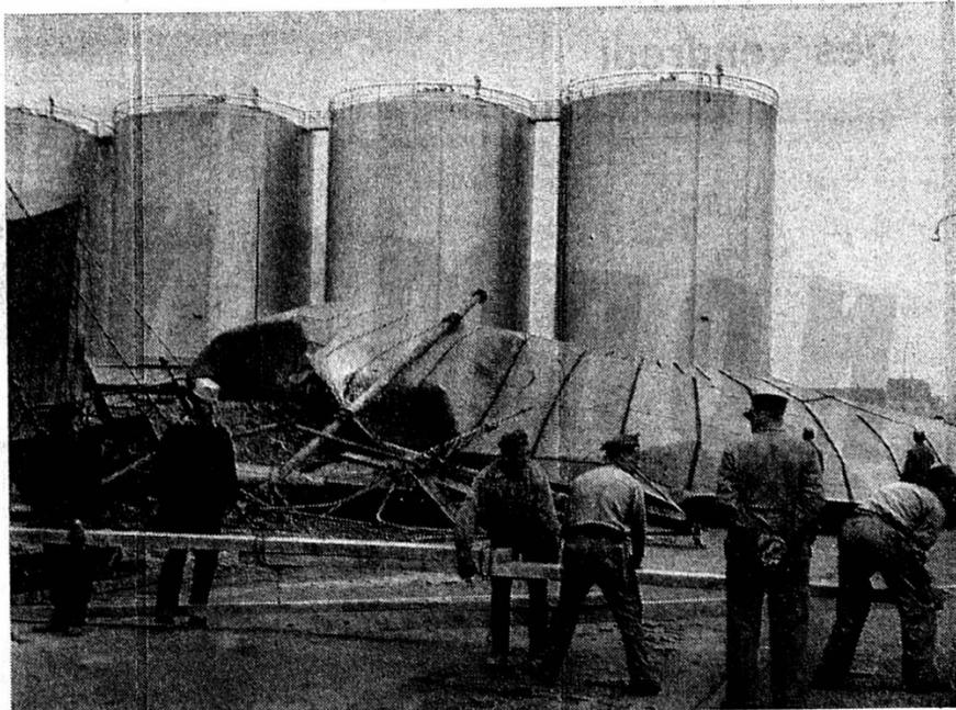
Un étrange accident est survenu à Muttens. Des vapeurs s'étant probablement échappées d'un grand réservoir, elles firent explosion au moment où passait une automobile. Le réservoir fut réduit en miettes.
